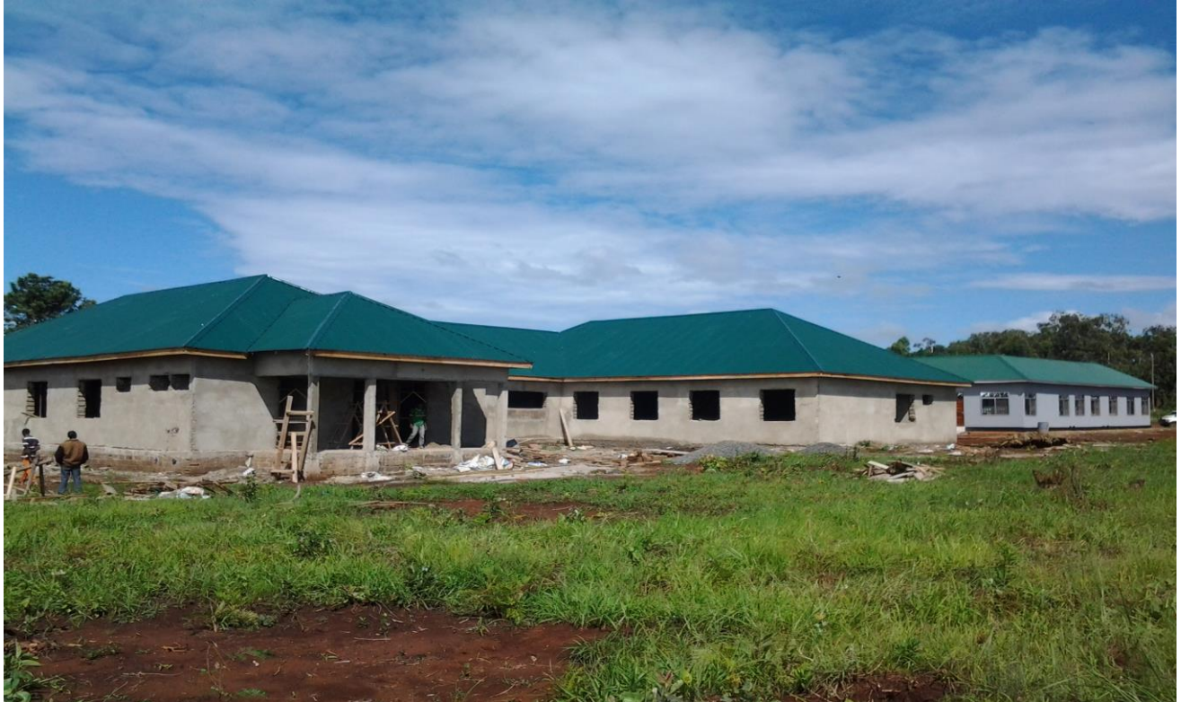
Mradi wa jengo la upasuaji katika kituo cha Afya Mbangamao Halmashauri ya Mji wa Mbinga
