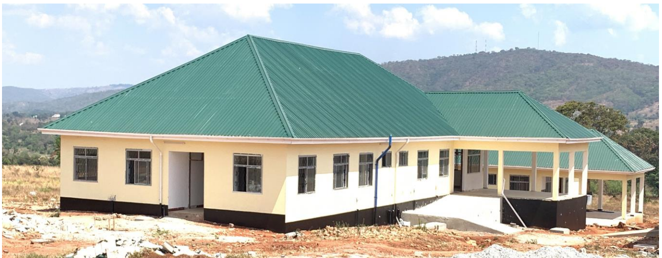
Moja ya majengo katika mradi wa ujenzi wa hospitali ya Madaba wilayani Songea mkoani Ruvuma
