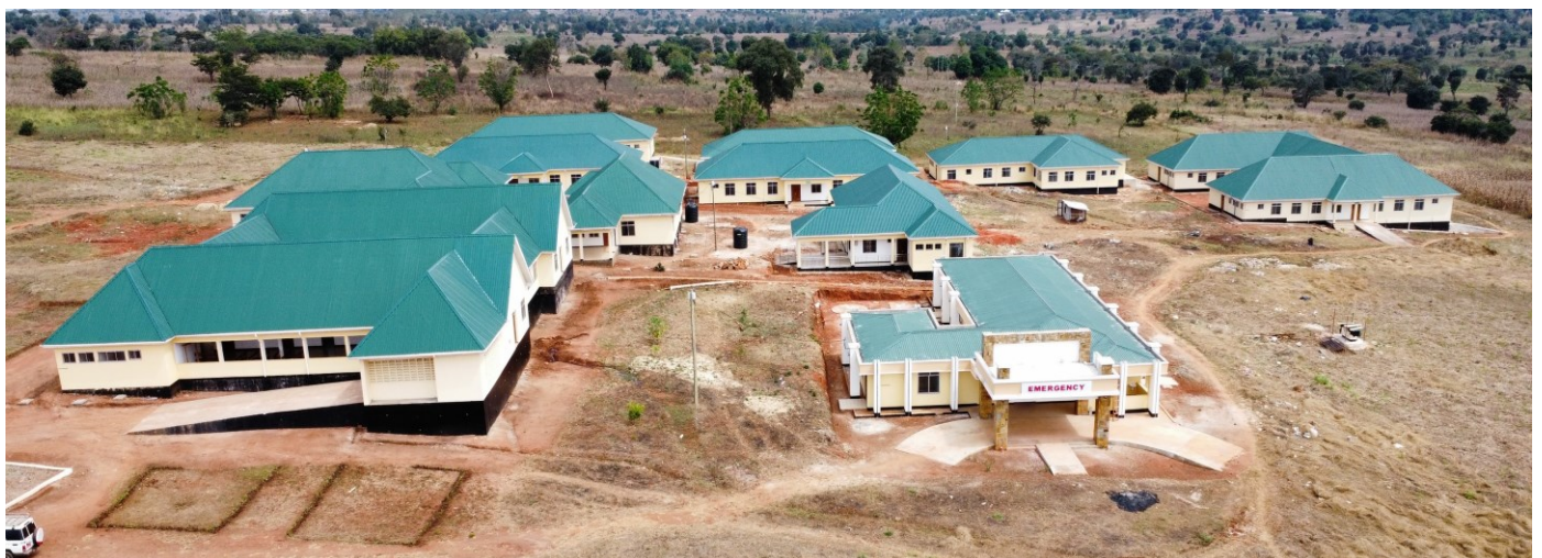
Muonekano wa baadhi ya majengo ya hospitali ya Halmashauri ya Madaba wilayani Songea
